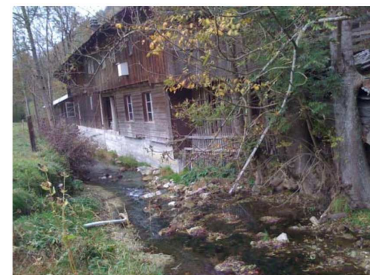
TRONÇON ÉVALUÉ, PHOTO BASLER & HOFMANN
