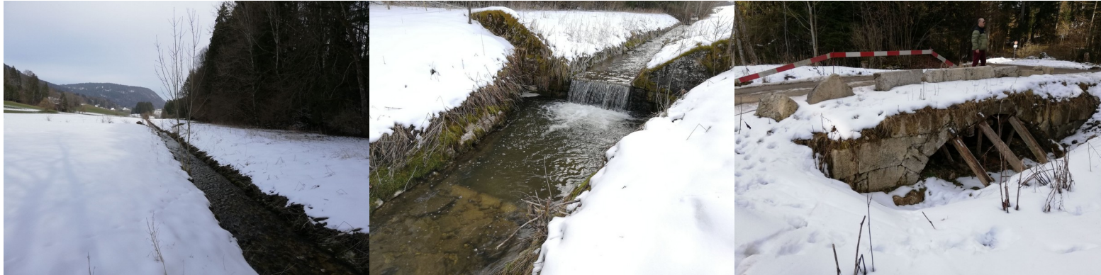
Photographies prises lors de la visite de terrain, 23.03.2021
