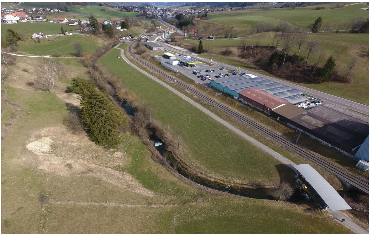
Photo de drone de la Birse, du pont vers l'aval, avril 2021 source : HBT
