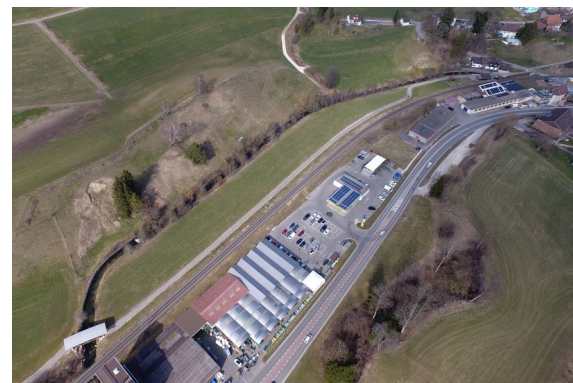
Photo de drone de la Birse, avril 2021 source : HBT
