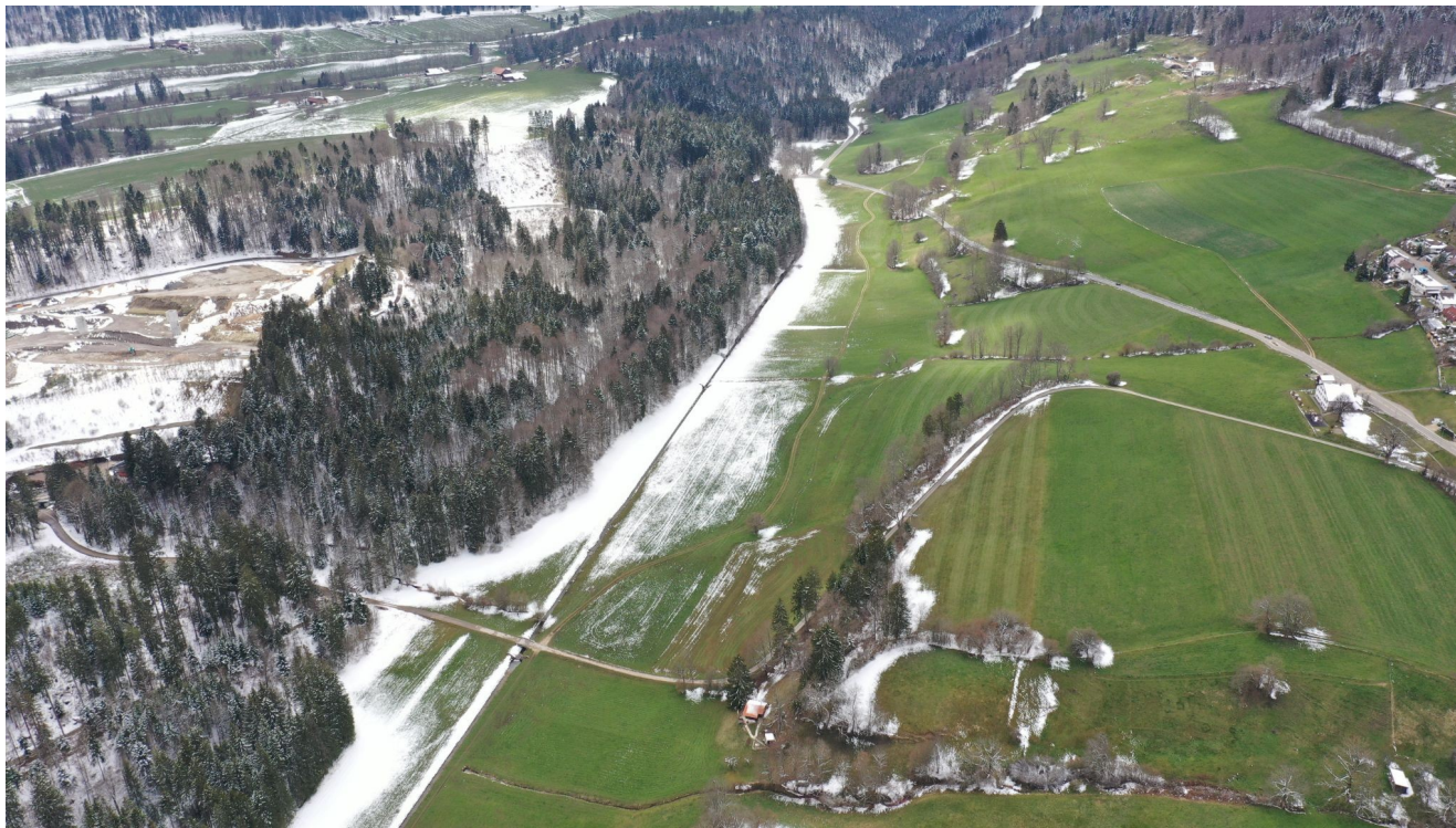
Photo de drone de la Trame, du pont historique vers l'amont, avril 2021 source : HBT
