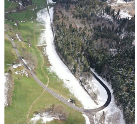
Photo de drone de la Trame avril 2021 source : HBT
