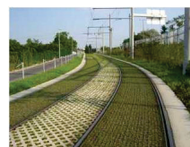
Station Liebenau - Graz, Autriche. Solution ECORASTER® sur les côtés et grille gazon en béton au centre.
