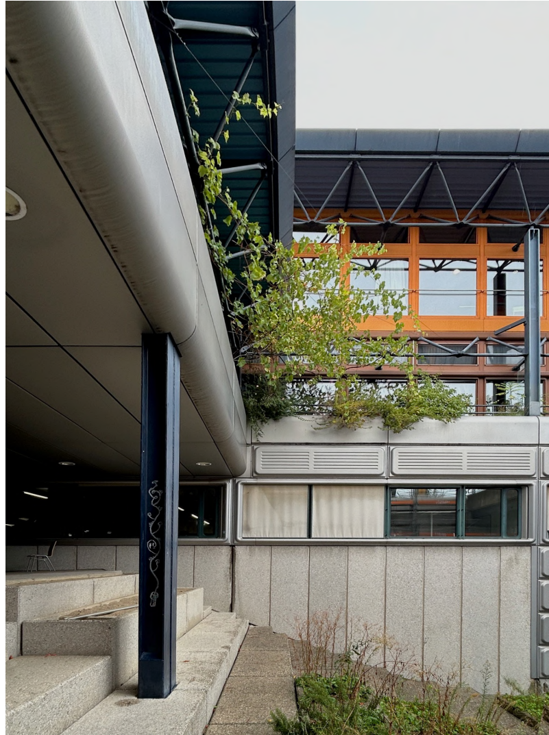
Exemple: Bâtiment CO, cour intérieure, campus EPFL
