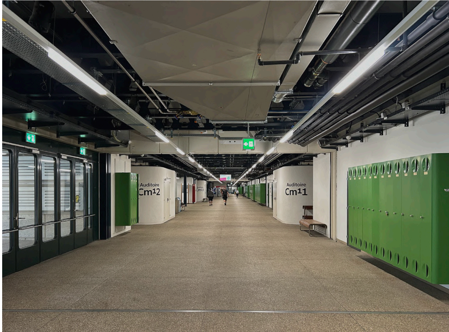
Exemple: Bâtiment CM, rue intérieure, campus EPFL
