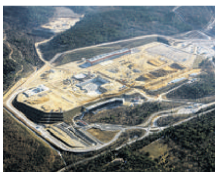
Le site où se construit ITER, à Cadarache (Saint-Paul-lès-Durance). DR
