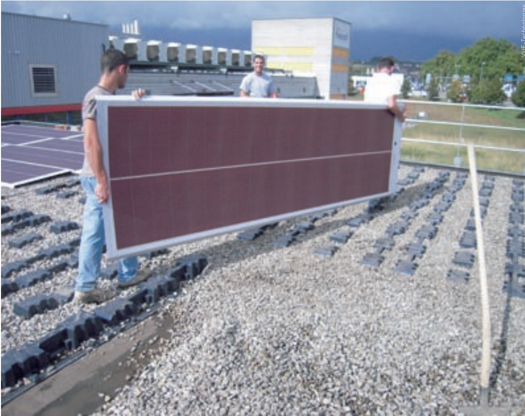
System für Flachdächer, die mit Kies bedeckt sind. Modul Flexcell FLX-M0 135 auf Stahlplatte.
