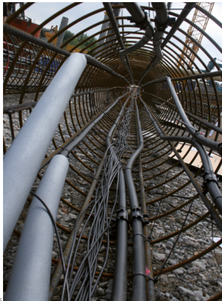
Fig. 5 : Equipement d'un pieu énergétique (Photo LMS-EPFL)
