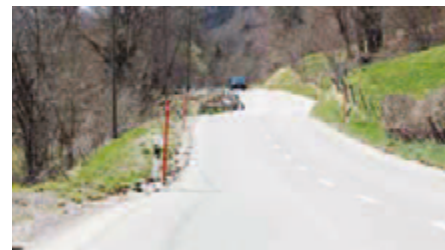
Le terrain n'est pas seul à descendre. Avec lui, les marques apposées par l'homme, mais aussi la chaussée et les cibles du système de surveillance continue du glissement.
