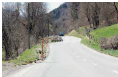
Le terrain n'est pas seul à descendre. Avec lui, les marques apposées par l'homme, mais aussi la chaussée et les cibles du système de surveillance continue du glissement.
