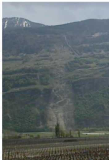
12. Dezember 2000 Rohrbruch Cleuson-Dix
