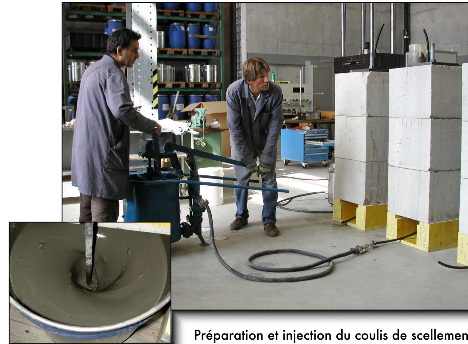
Préparation et injection du coulis de scellement
