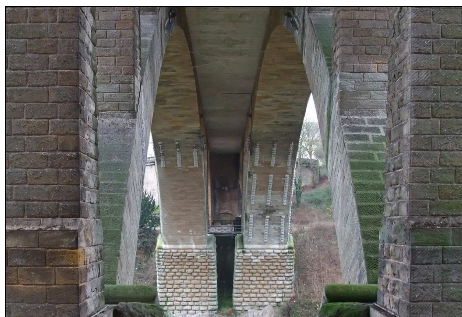
Renforcement provisoire de l'arche par cloutage
