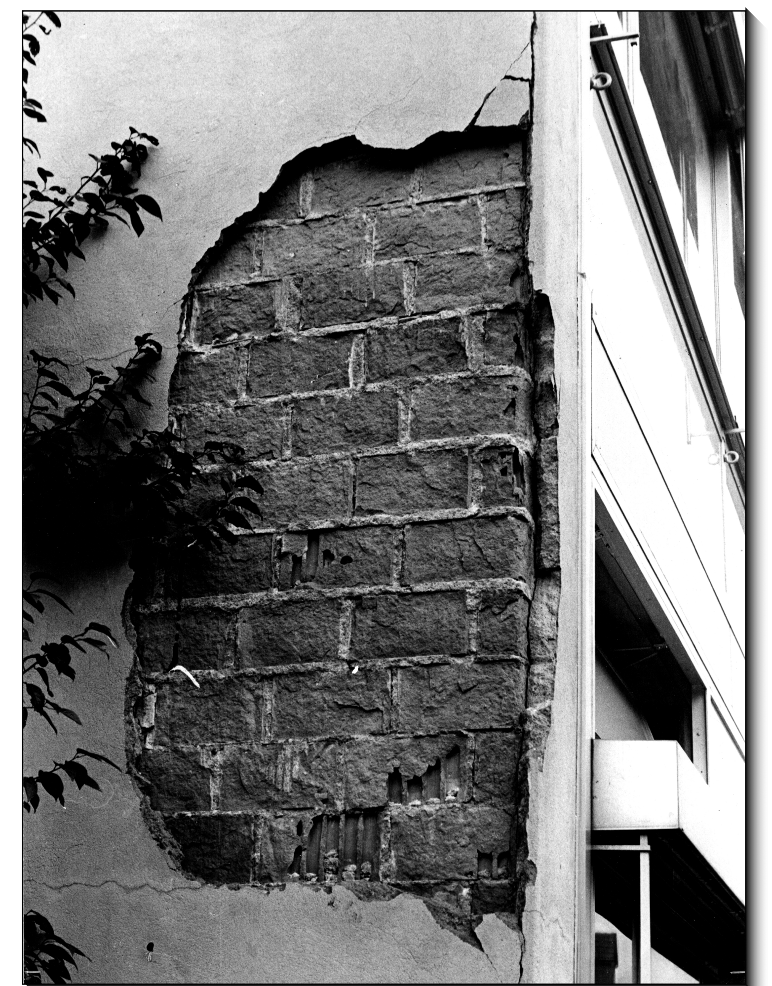
Rupture d'un enduit par gel en profondeur
