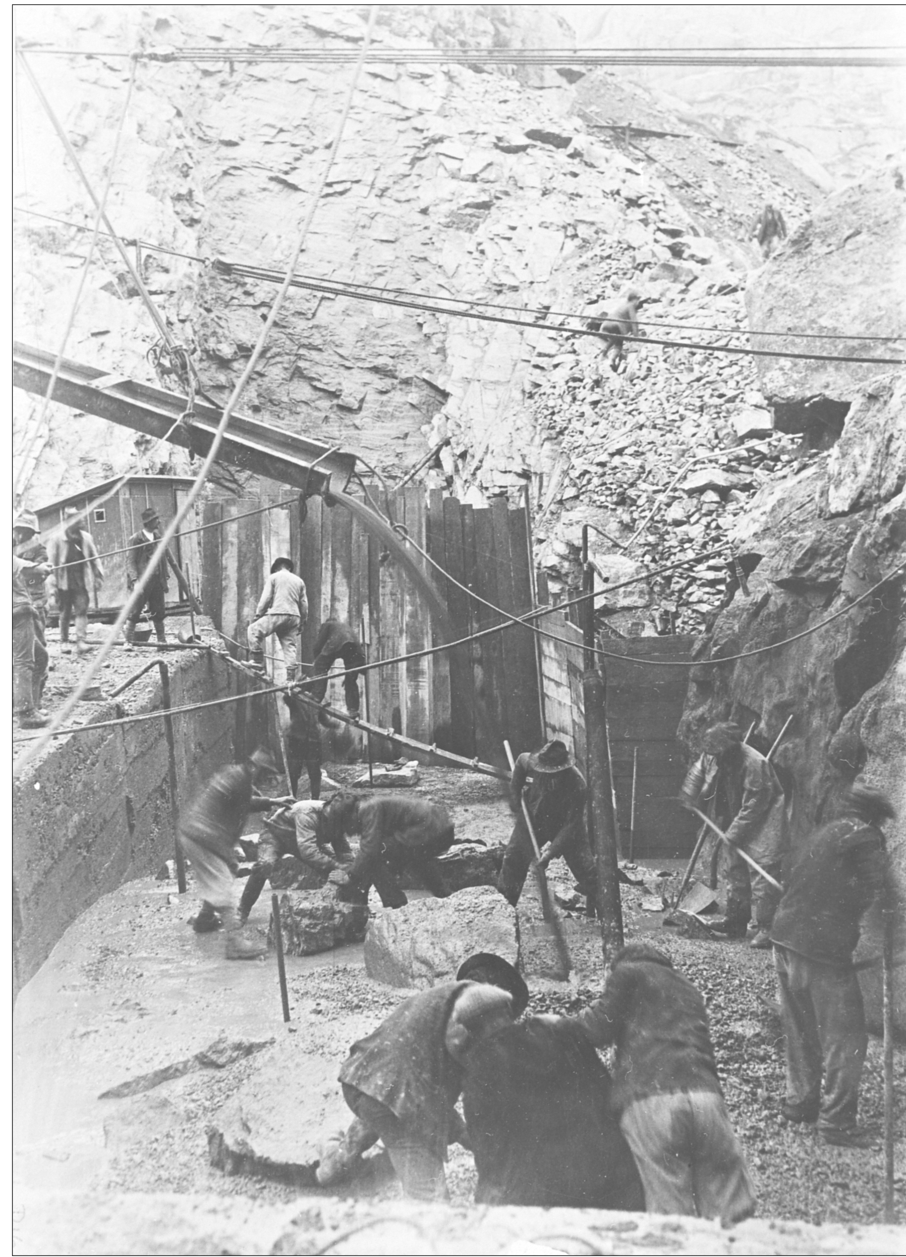
Bétonnage des fondations
