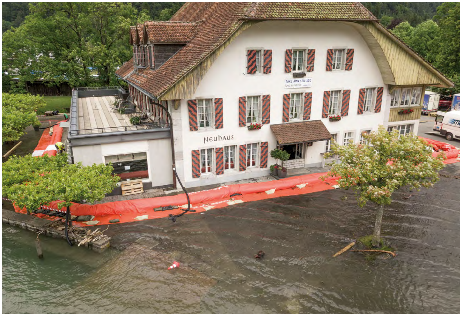
Des digues mobiles – un cadeau de la Mobilière à la région d'Interlaken – ont permis d'éviter des dégâts lors des intempéries de l'été 2021.
