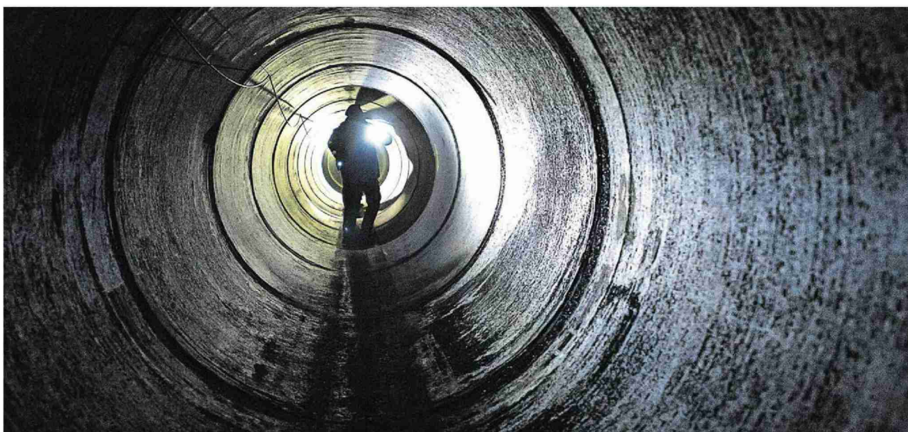
Physische Inspektion der Ablaufleitungen in der Basler ARA: Die Covid-19-Analysen werden dagegen in Labors vorgenommen.
