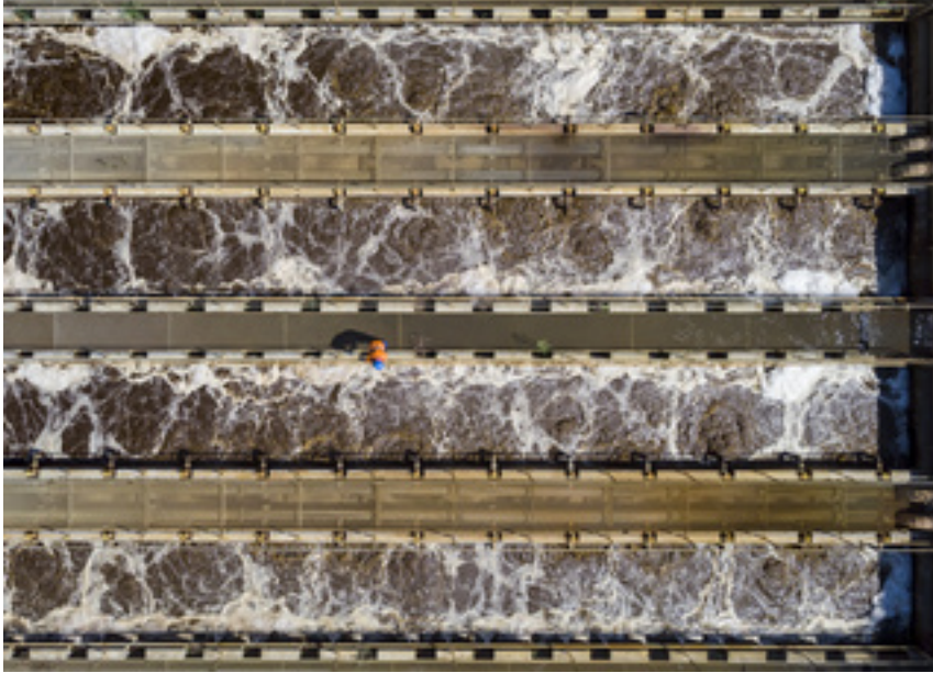
La station d'épuration de Vidy, près de Lausanne. | Keystone / Jean-Christophe Bott
