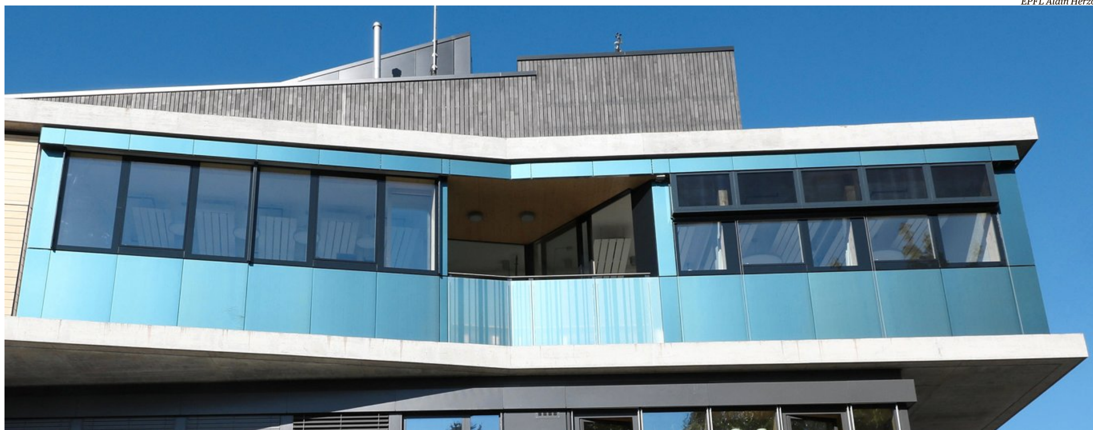
Les façades au reflet bleu de l'unité SolAce dissimulent des cellules photovoltaïques (électricité) et capteurs thermiques (eau chaude) qui suffisent à alimenter en énergie l'appartement de 100 m 2 .
