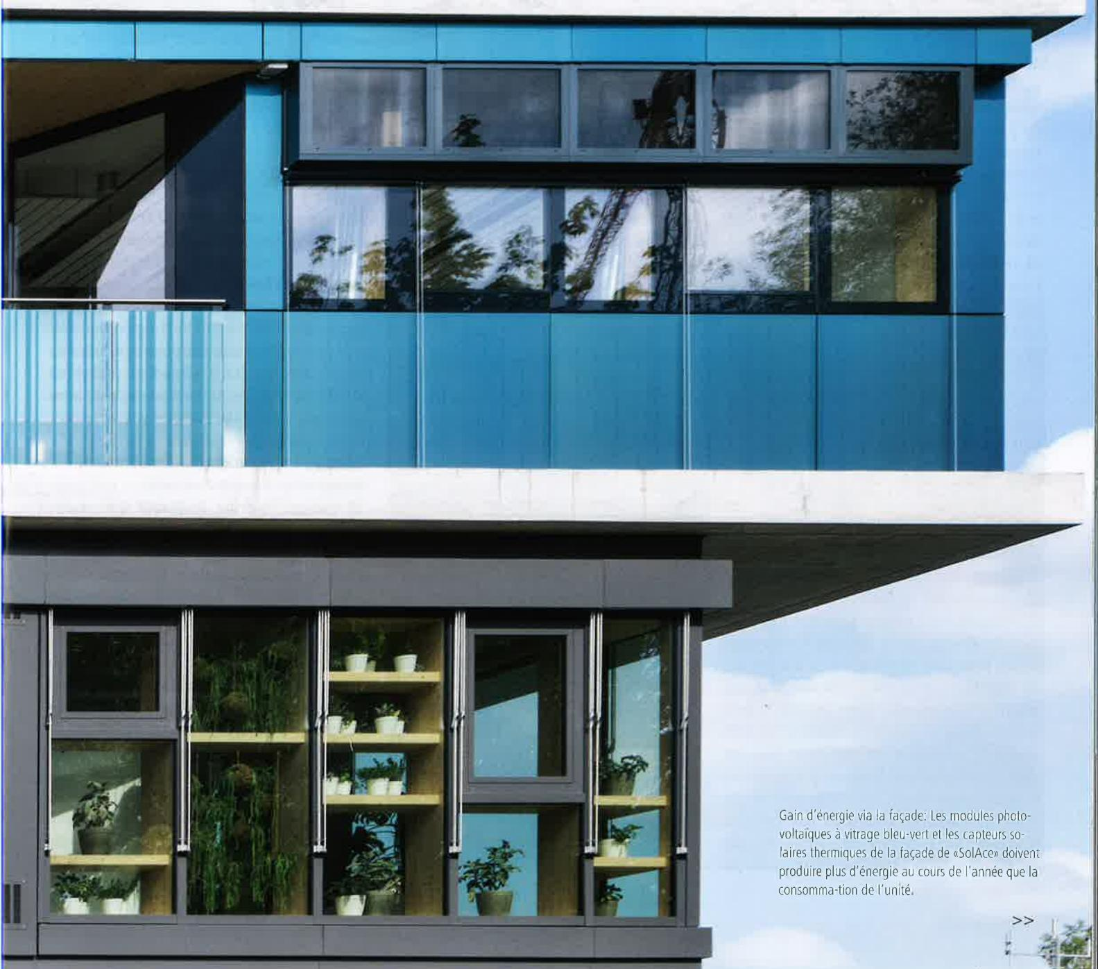
Gain d'énergie via la façade: Les modules photovoltaïques à vitrage bleu-vert et les capteurs solaires thermiques de la façade de «SolAce» doivent produire plus d'énergie au cours de l'année que la consommation de l'unité.
