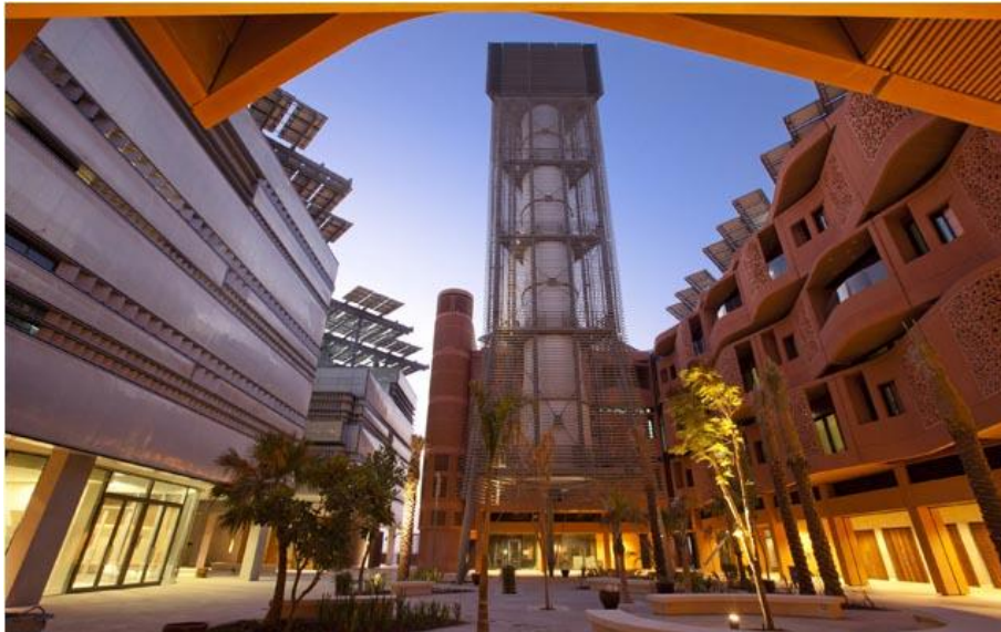
Figura 46 Masdar. Torre del vento. Tratto dal sito di Masdar
