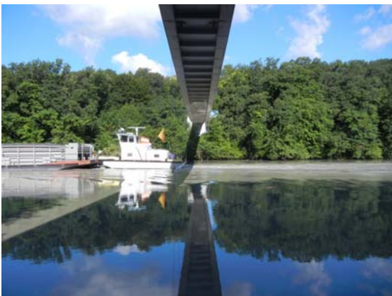
Figure 1 : Passerelle du Lignon avec la poutre pendant le passage du convoi / Bridge of Lignon with suspended beam during convoy passage
