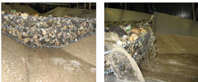
Figure 2 : Dépôts accumulés derrière le filet
