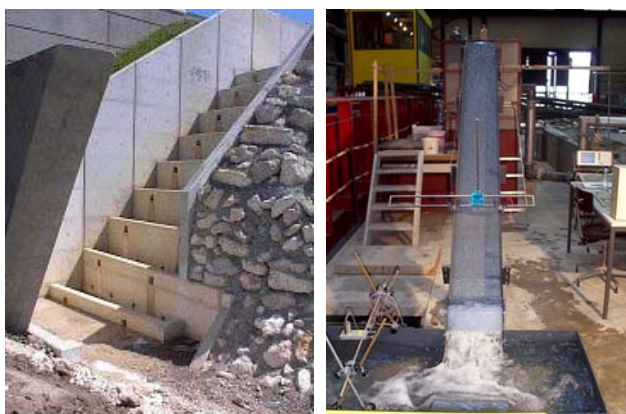
Figure 1: A gauche, descente d'eau pluviale en escalier type DE04 à Avignon (FR) , à droite, modèle réduit de la descente lisse type DE03.
