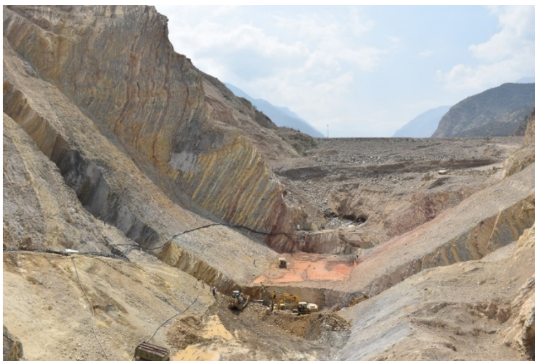
Chantier du barrage Haraz, excavation pour barrage en remblai, contact du noyau en argile avec rocher ; tranchée par la galerie au pied du noyau.
