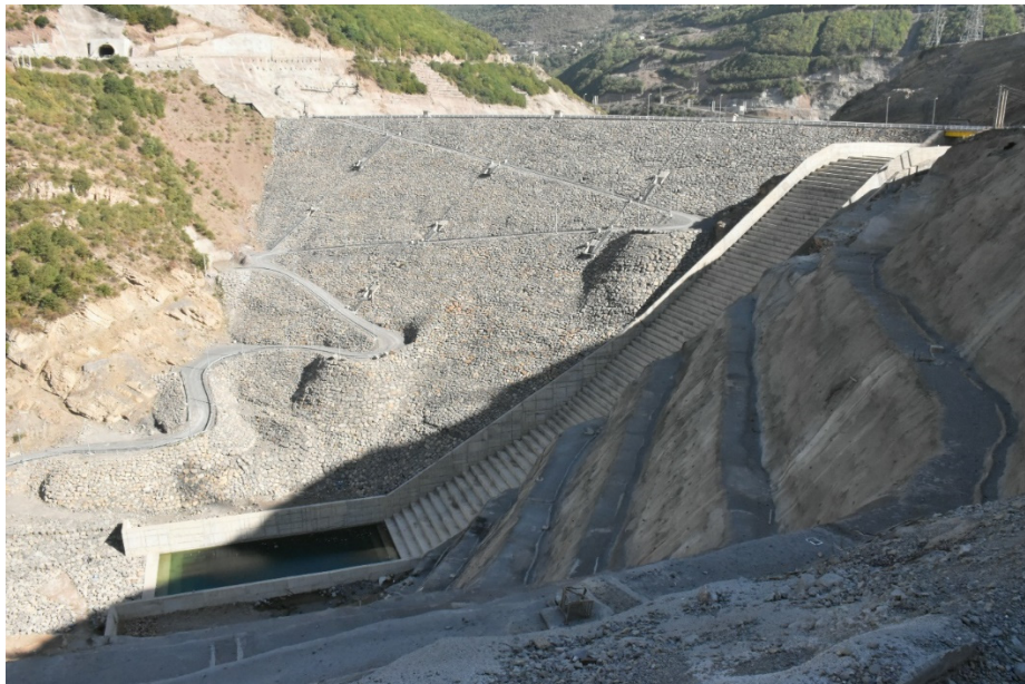
Barrage Siah Bisheh avec l'évacuateur en marches d'escalier.
