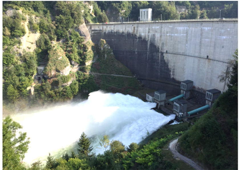
Ouverture des vindages de fond à Rossens
