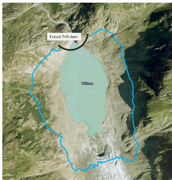
Figure 1: Vue en plan de la retenue du futur barrage de Trift, variante avec retenue normal à 1767 msm.
