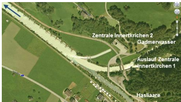
Figure 1: Restitution des centrales Innertkirchen 1 et 2 avant la construction du bassin de démodulation. / Tailrace outlets of the Innertkirchen 1 and 2 powerplants before the construction of the compensation basin.
