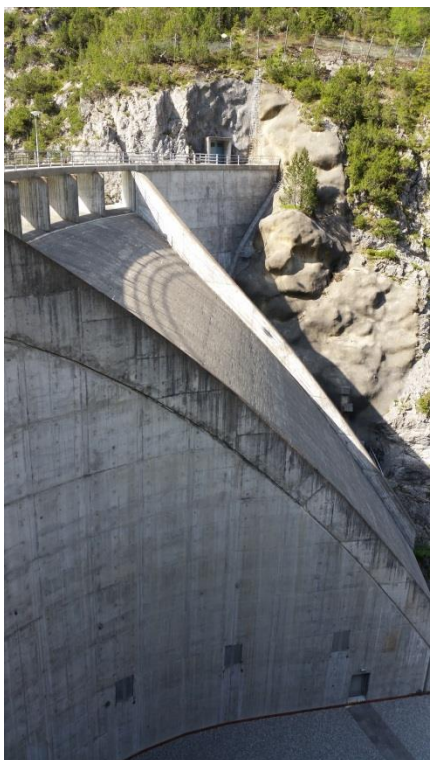
Evacuateur de crue du barrage d'Ova Spin
