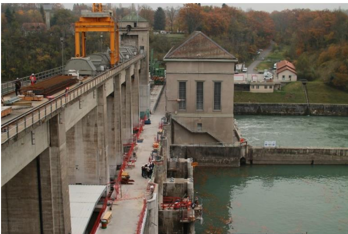
Photo 1 : Travaux de mise en conformité aux normes sismiques
