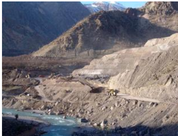
Figure 1: Le barrage de Rubdar Lorestan en construction ( http://en.iwpc.ir/Rudbar )
