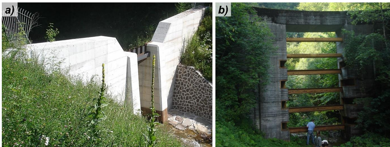
Figure 1: Illustration des deux types de barrages filtrants considérés dans ce projet de recherche, (a) un barrage avec une crête ouverte et (b) un barrage avec une crête fermée (Trento, Italie)
