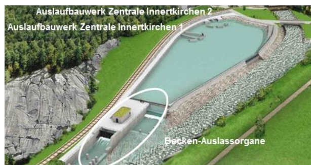
Figure 2: Partie à ciel ouvert du bassin de démodulation des débits turbinés dans les centrales Innertkirchen 1 et 2 / Open-air volume of the compensation basin for the outflow discharges of the Innertkirchen 1 and 2 powerplants.
