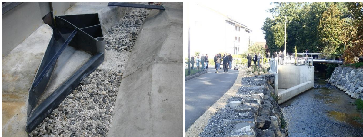
Photos de l'ouvrage de dérivation de l'Abrogne à Corcelles-près-Payerne, à gauche le modèle au LCH (échelle 1:20) à droite lors de l'inauguration.
