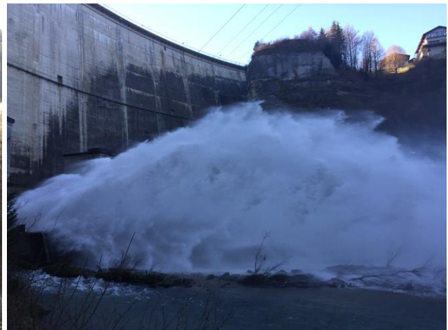
L'ouverture des vannes au Barrage de Rossens
