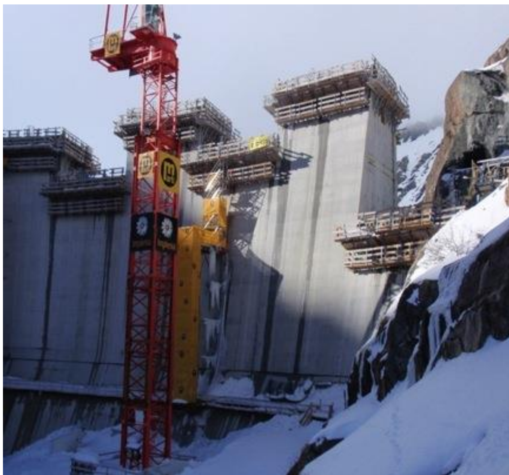
Figure 1 : Surélévation du barrage de Vieux-Emosson intégré à la station de transfert d'électricité par pompage de Nant de Drance (900 MW). Photo A. Schleiss (nov. 2013).
