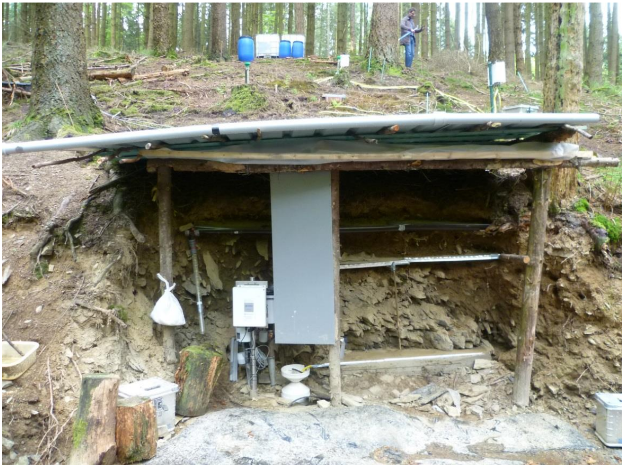
Installation pour les expériences in situ suivies par Keith Beven.
