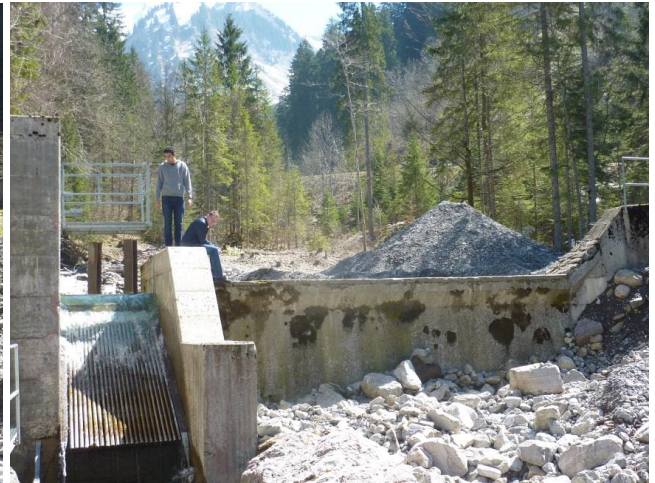
Prise d'eau tyrolienne.
