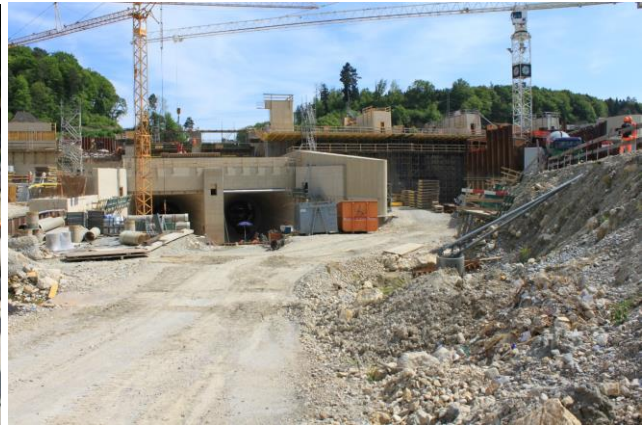
Vue depuis l'aval du chantier la sortie des deux turbines après le bétonnage de l'usine
