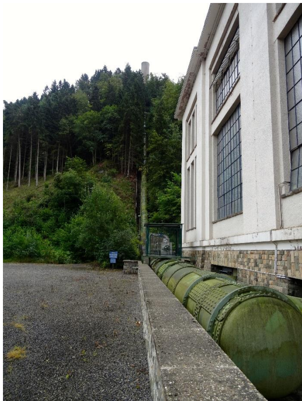
Centrale hydroélectrique de Bévercé avec sa conduite forcée et sa chemine d'équilibre.
