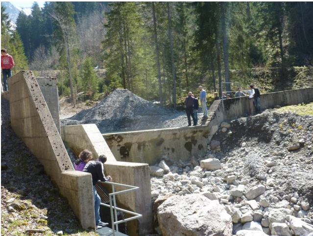
Vue depuis l'aval de la prise d'eau avec évacuateur de crue.
