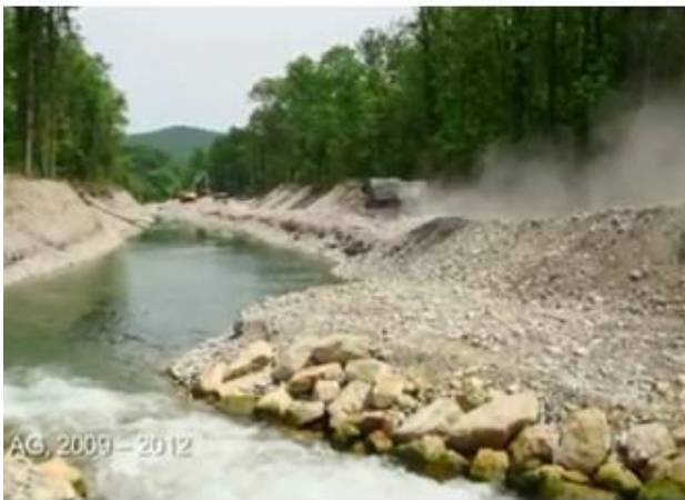
Figure 1 : Exemples de réapprovisionnement en sédiments : (gauche) le réapprovisionnement au Canton de Argovie, Suisse, entre 2009 et 2012; (droite) du réapprovisionnement en sédiments à la rivière Sacramento aval le barrage Keswick
