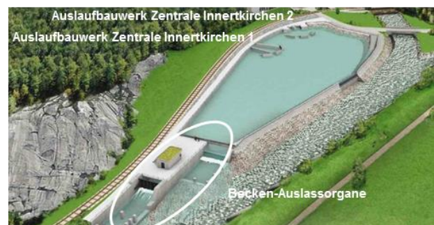
Figure 2 : Bassin de rétention pour l'eau turbinée dans les centrales Innertkirchen 1 et 2 / Retention basin for the turbinéd water of the power plants Innertkirchen 1 and 2.
