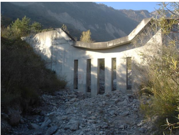
Barrage filtrant dans le Manival (Isère, France)
