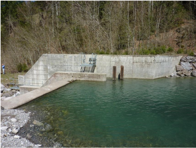
Retenue devant la prise d'eau (vue depuis l'amont).
