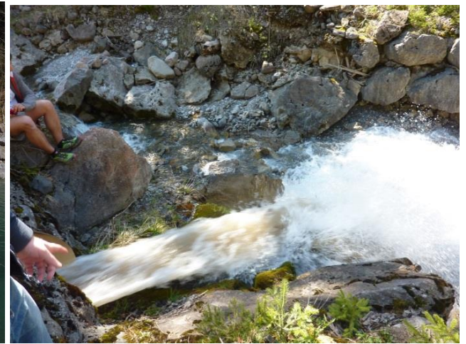
Jet d'eau avec sable à la sortie du canal de purge du dessableur.
