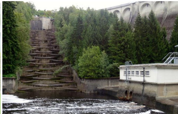
« Stepped spillway » du Barrage d'Eupen
