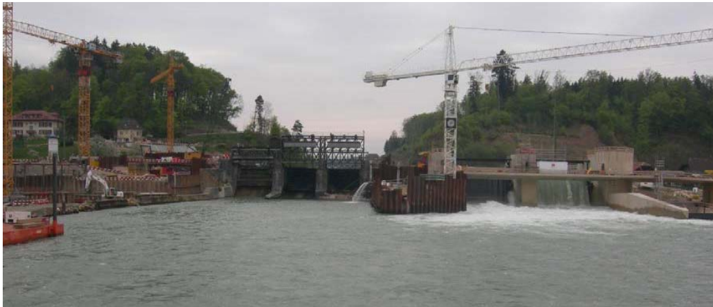
Vue depuis l'aval du chantier, les deux premières vannes déjà mises en service et la construction des batardeaux de la deuxième phase de construction pour les deux autres passes du barrage, ainsi que la nouvelle usine en rive droite
