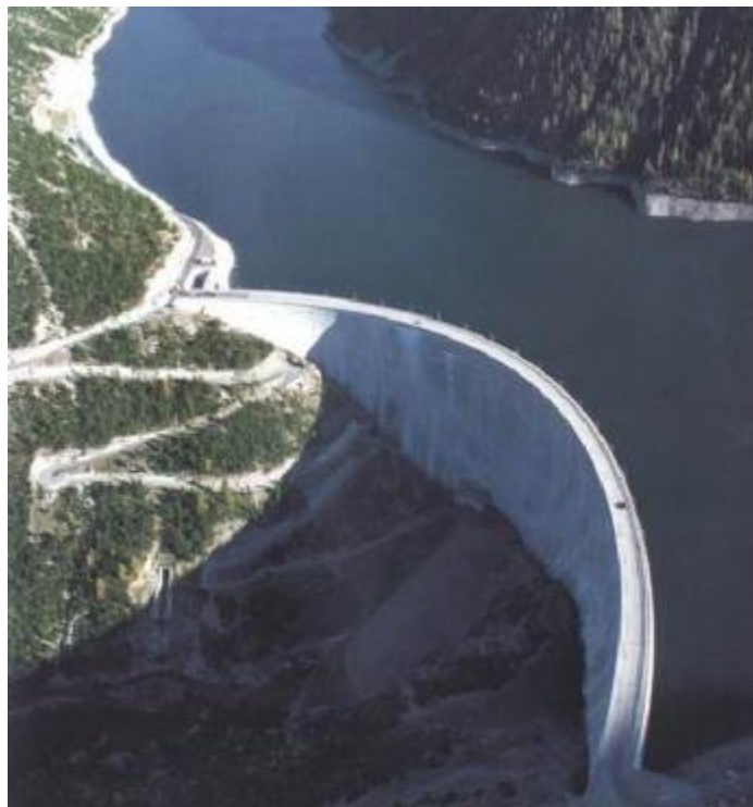
Figure 1 : Vue aérienne du barrage Punt dal Gall
