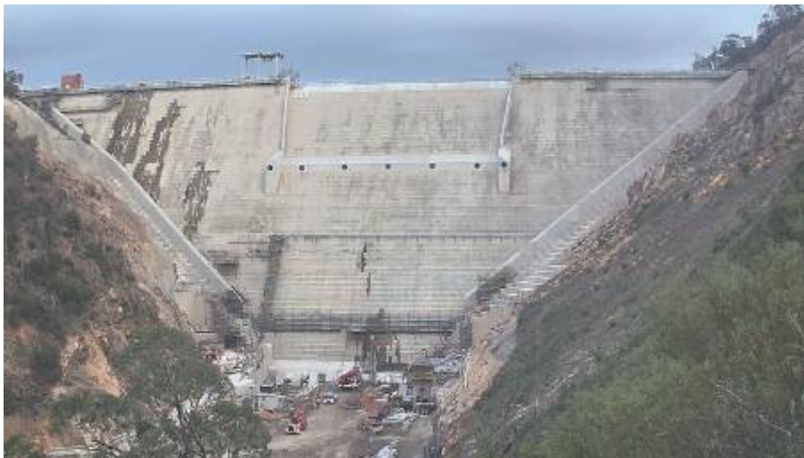
Figure 1 : Déversoir en marche d'escalier sur le barrage de Cotter, Australie (source : ACTEW)
