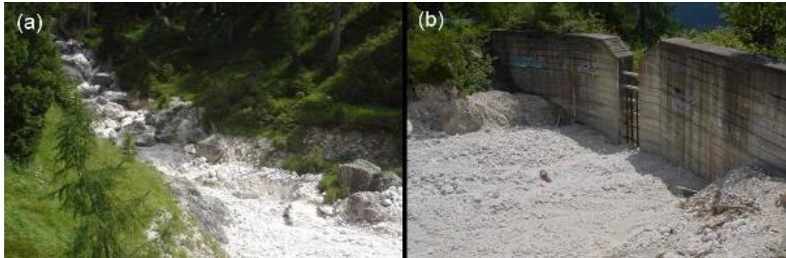
Figure 1: Illustration (a) d'un torrent alpin typique et (b) d'un barrage de correction de torrent excavé récemment qui se trouvent dans la région de Trente (Italie).
