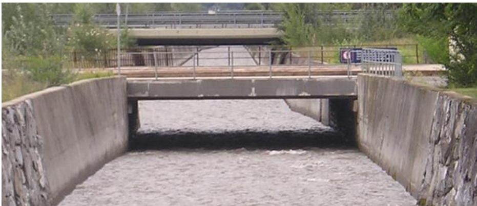
Figure 1 : Pont CFF avant travaux - vue depuis l'amont
