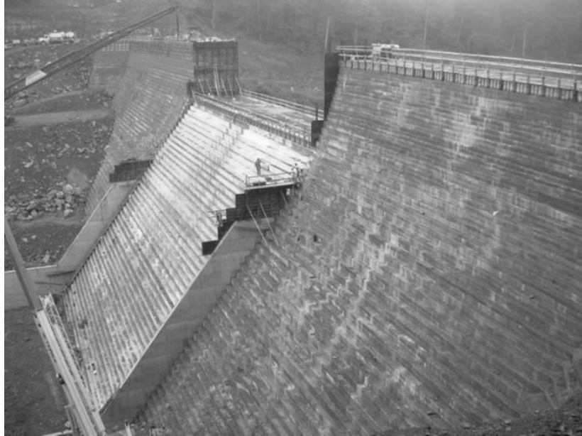
Figure 1 : Déversoir en marche d'escalier sur le barrage d'Elkwater Fork (US, Reichler Engineering)
