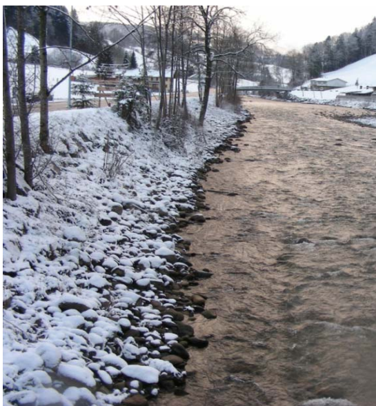
Figure 1 : Vue de l'enrochement de la rivière de Kleine Emme, Lucerne, Suisse / View of the river bank riprap protection of Kleine Emme river, Lucerne, Switzerland
