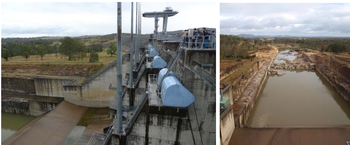
Wivenhoe Dam : Evacuateurs de crue (à gauche) et bassin amortisseur (à droite), avec les blocs éjectés de la fosse d'érosion par la crue de janvier 2011 ( Q_{\max} = 7'500 \text{ m}^3/\text{s} = 1.5 \times Q_{\dim} )
