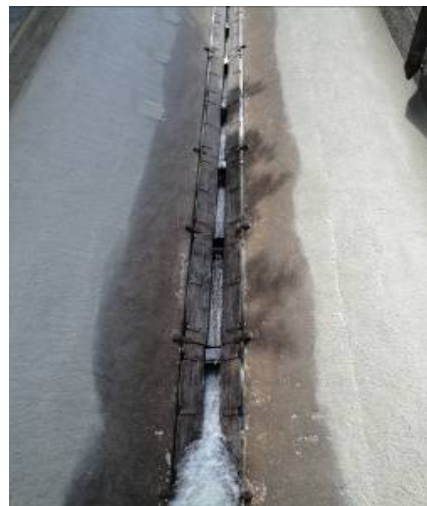
Figure 1: Dépôts des sédiments après la purge (à gauche) et vue des appareils purgeurs (à droite) / The sediment deposit after the flushing (left) and view of the wooden planks (right)
