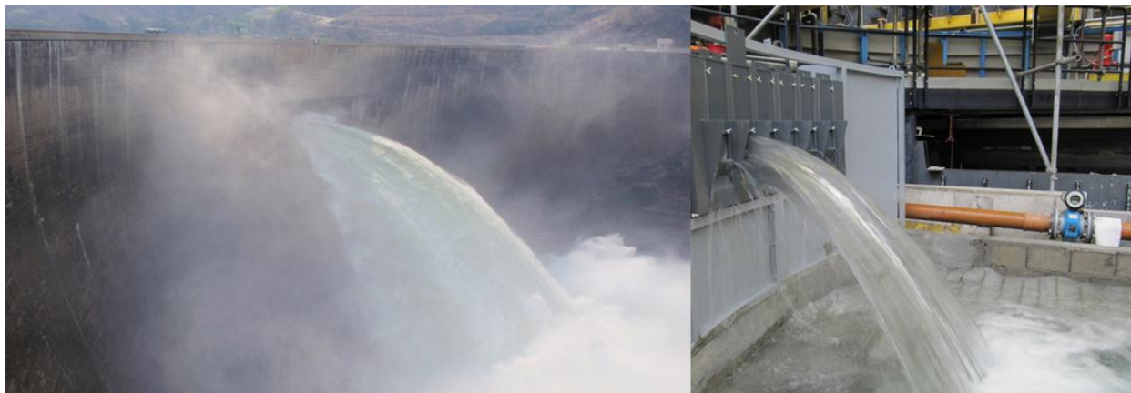
Figure 1: a) jet créé par le déversoir vanné du barrage de Kariba; b) jet similaire sur modèle physique / a) jet generated by the gated spillway of the Kariba Dam; b) similar jet on physical model
