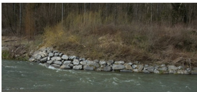
Figure 1 : Protection du pied de berge à enlever en rive gauche / Toeslope protection to remove on the left side of the river
