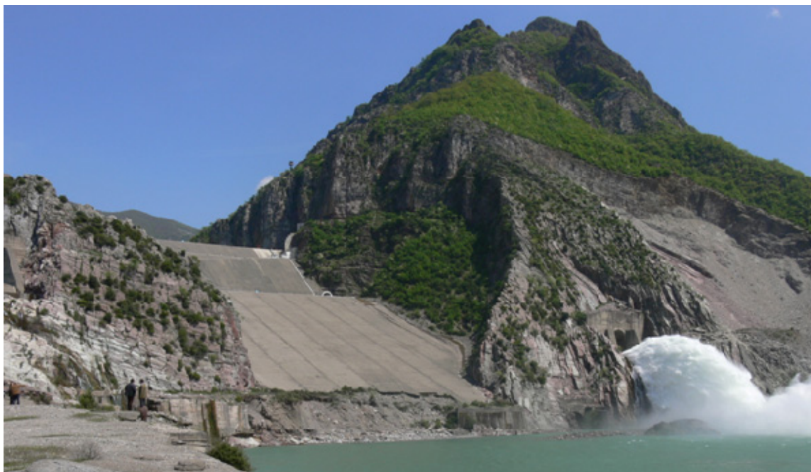
Vue aval du barrage de Koman, avec l'évacuateur No.3 en fonction avec env. 100 m 3 /s, la capacité étant de 1'900 m 3 /s (!) et la face aval avec son pied de barrage érodé.
