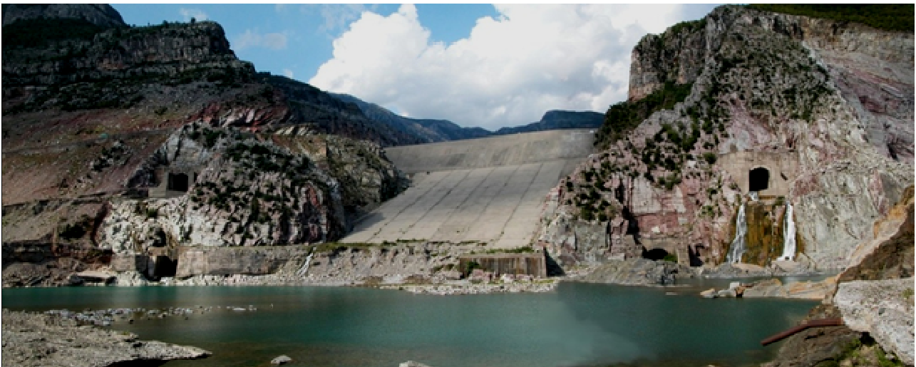
Figure 1 : Vue de la face aval du barrage de Koman avec la partie érodée de pied du barrage et deux évacuateurs de crue / View of the downstream face of the Koman dam with eroded dam toe and the outlet works
