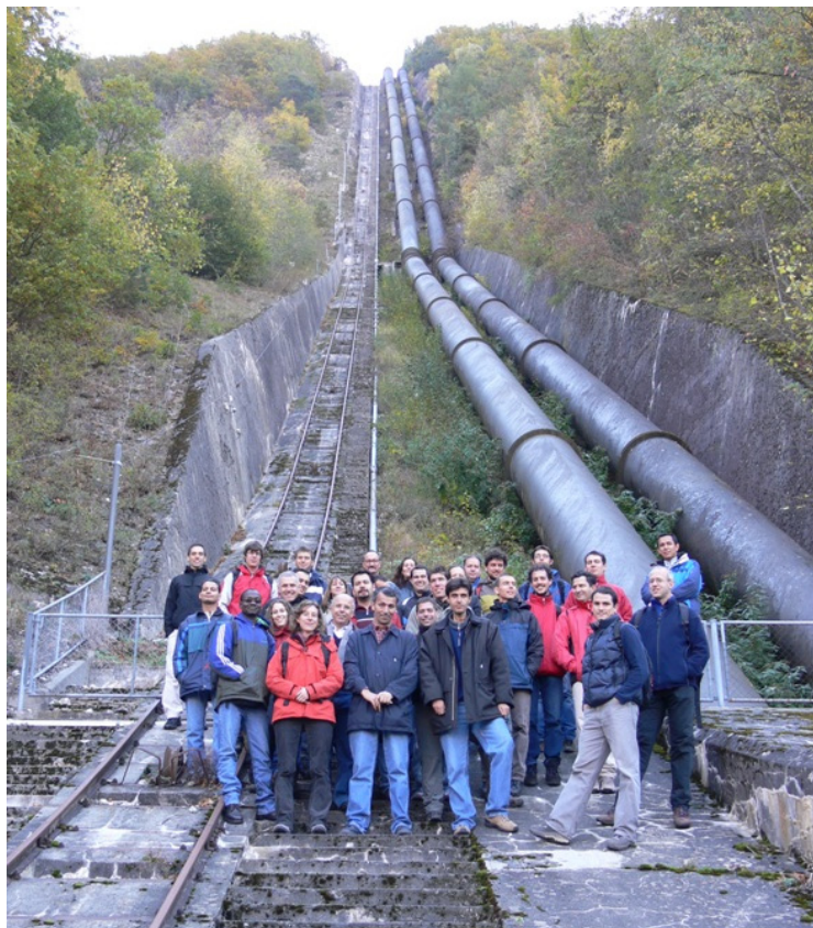
Excursion à Mauvoisin – photo de groupe devant la conduite forcée de la centrale de Riddes / Excursion to Mauvoisin – group photograph at the Riddes powerplant penstock
