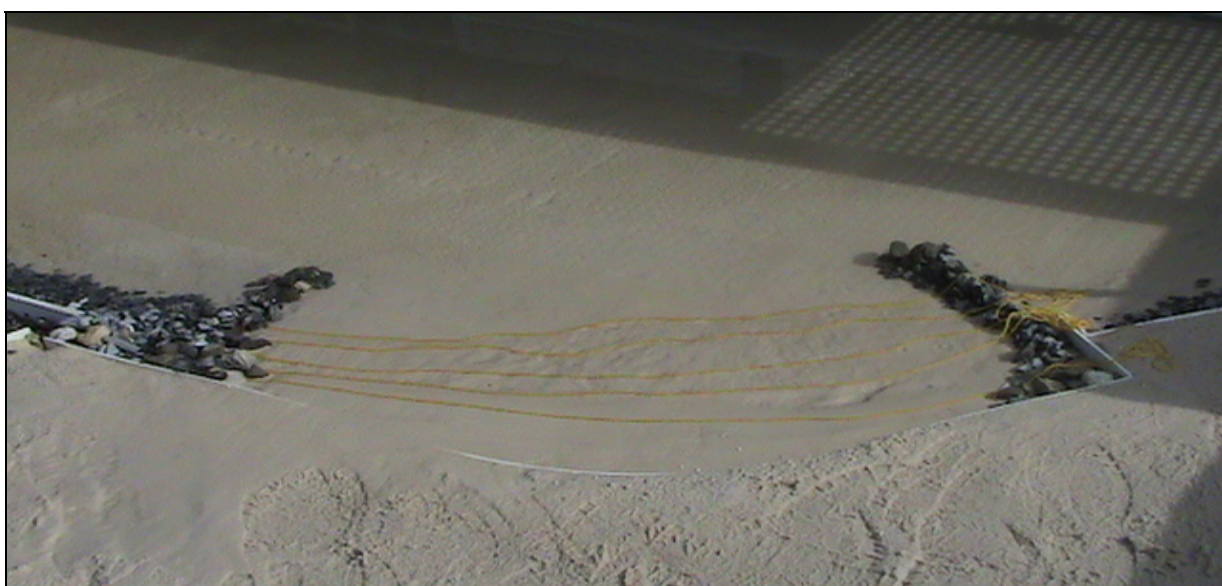
Figure 4: Plage à l'amont du port avec épis de protection / Beach upstream of the harbour with protection groynes
