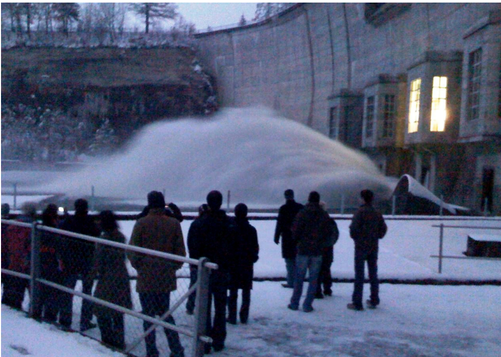
Essais de vidange de fonds du barrage de Schiffenen
