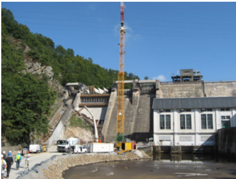
Le déversoir PK-Weir du barrage de Saint-Marc sur la rivière Taurion près de Limoges , France
