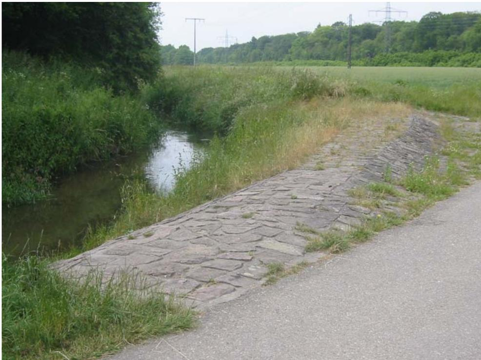
Figure 1: Déversoir latéral sur la rivière Erlengraben près de Karlsruhe, sud de l'Allemagne / *Side overflow dam on the river Erlengraben, Karlsruhe, South of Germany*
