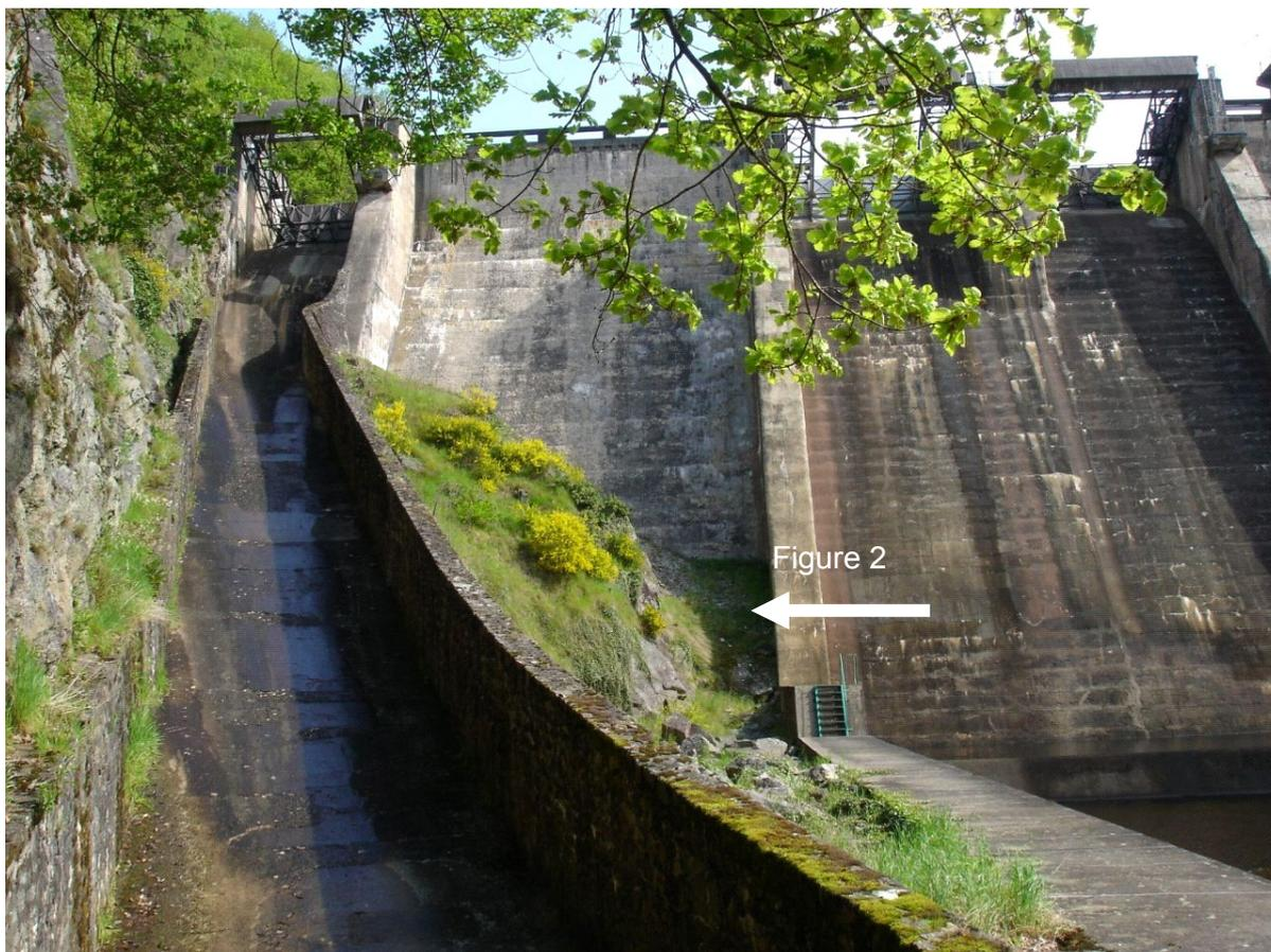
Figure 1: Vue depuis l'aval du chenal de l'évacuateur droit du barrage de St-Marc / Downstream view of the right bank spillway channel
