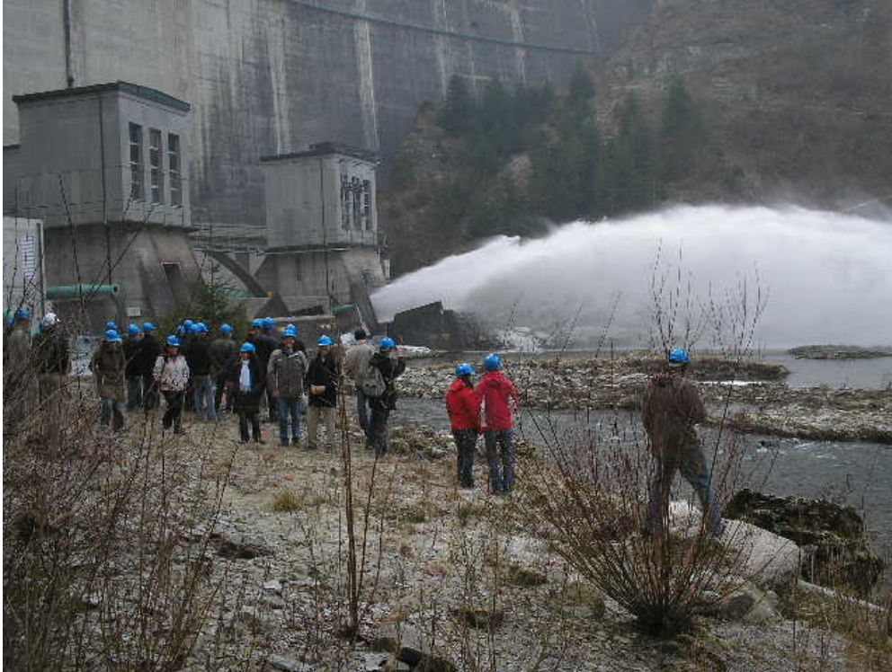
Barrage de Rossens (31 janvier 2006) / Rossens dam (31 st January 2006)
