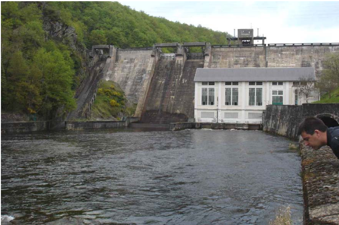
Figure 1a: Vue depuis l'aval du barrage de St-Marc / Downstream view of the St-Marc Dam
