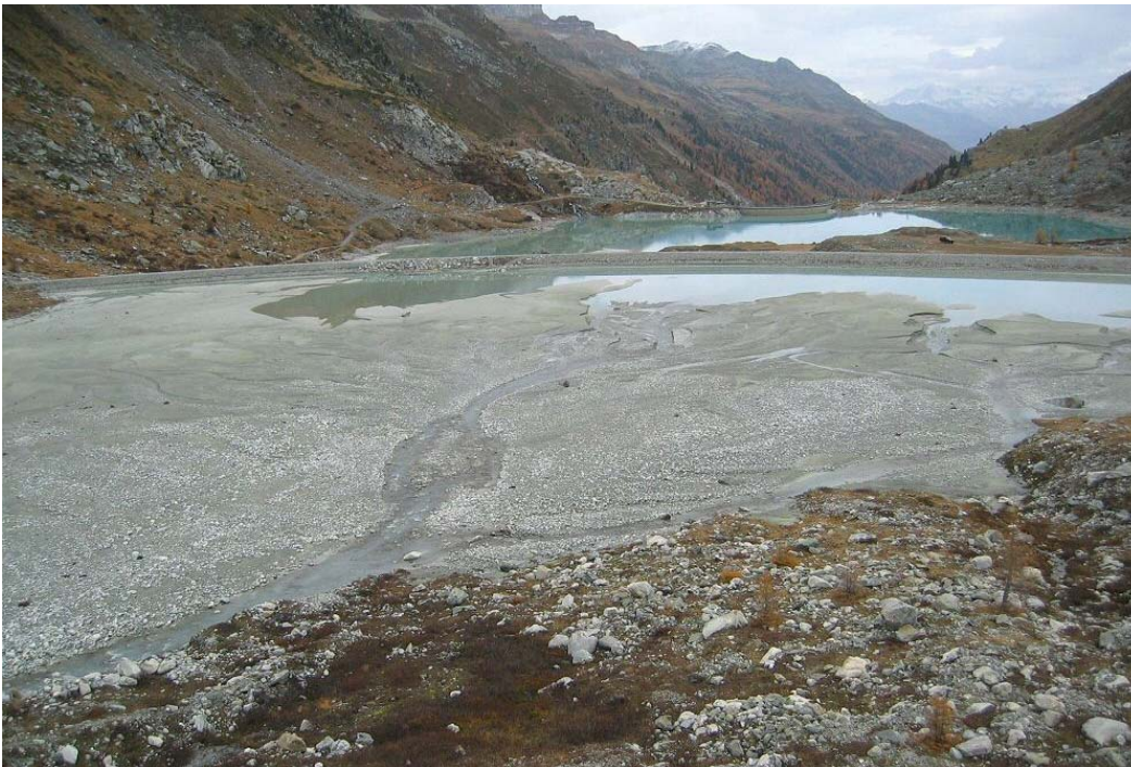
Figure 1 : Vue générale du bassin de décantation (au premier plan) et de la retenue de Tourtemagne (au fond) / General view of the sediment trap (foreground) and of the Tourtemagne reservoir (background)
