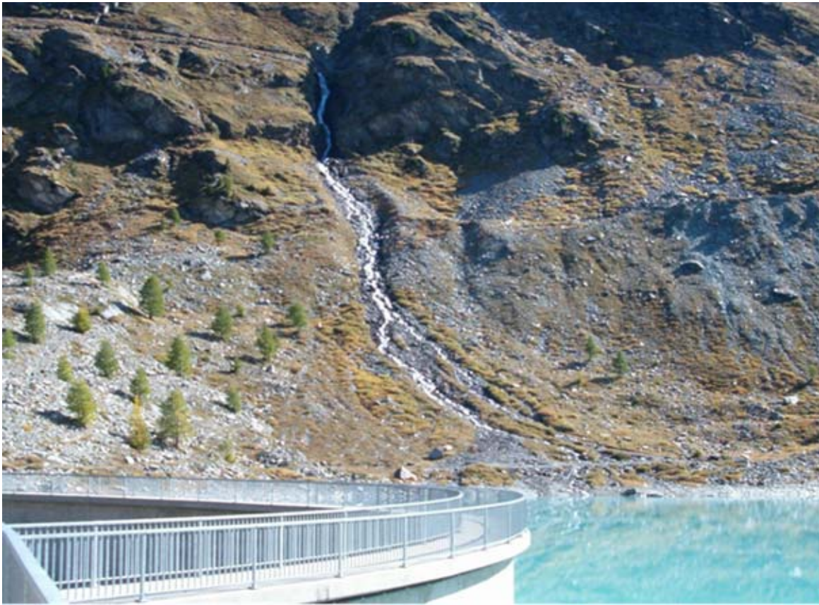
Figure 1: Adduction est dans le lac de Tourtemagne. Le potentiel de telles adductions sera vérifié pour la remobilisation des sédiments des réservoirs. Voilà un débit moyen de Q = 0.8 \text{ m}^3/\text{s} et une hauteur de chute de h = 170 \text{ m} . / Eastern afflux of water transfer tunnel in Lake Turtmann. The potential of such affluxes is going to be validated for the releasing process of the sediments out of the reservoir. The present mean discharge is Q = 0.8 \text{ m}^3/\text{s} and the head is h = 170 \text{ m}
