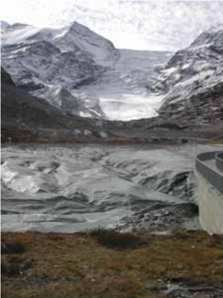
Figure 2: A gauche: Sedimentation dans le reservoir Tourt-magne et en haut: vue aval du barrage / Left: Sedimentation behind the Tourtmane dam and above downstream view of the dam
