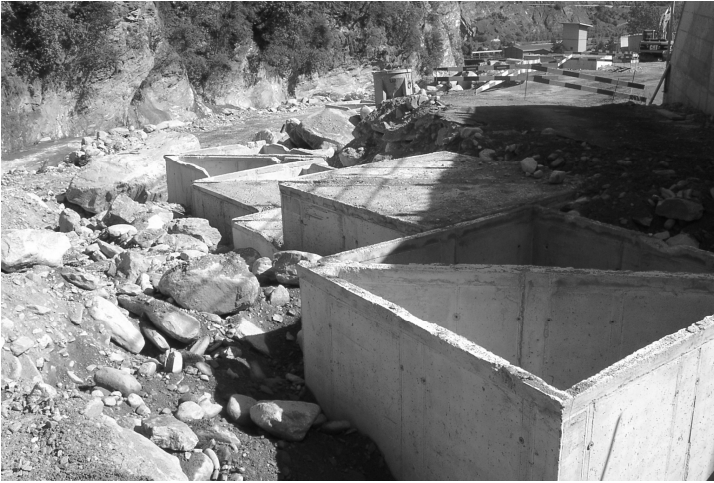
Figure 1: Epi lors de sa construction avec des demis cubes en béton d'une taille de 2.8 m et d'un poids de 27 t après remplissage ; vue vers l'aval dans le périmètre de la Société Suisse des Explosifs / Groin during its construction with half concrete cubes (size: 2.8 m; weight: 27 t after filling); view downstream in the vicinity of the "Société Suisse des Explosifs"
