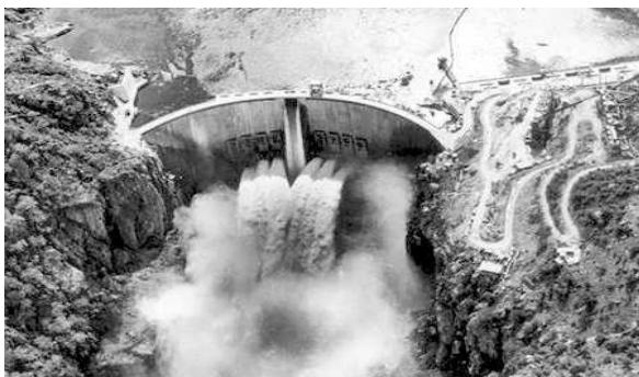
Figure 1: Ecoulement à travers 6 des 8 évacuateurs de crue munis de vannes du barrage de Cabora-Bassa / Discharge through 6 of the 8 orifice spillways at Cabora-Bassa dam, Mozambique
