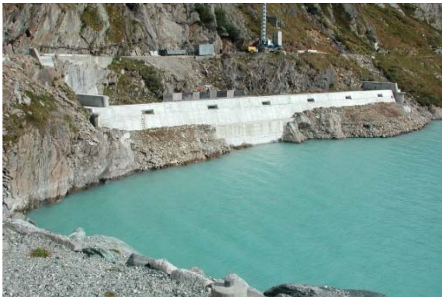
Figure 1: Vue du nouvel évacuateur de crue / View of the new spillway of the Mattmark dam
