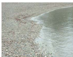
Remblai en gravier Gravel armouring
