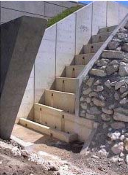
Figure 4: A gauche: Descente d'eau pluviale en escalier type DE04 à Avignon (France), à droite: Modèle réduit de la descente lisse type DE03 / Left: The stepped energy dissipating structure type DE04 at Avignon (France). Right: The physical model of the smooth energy dissipating structure type DE03.
