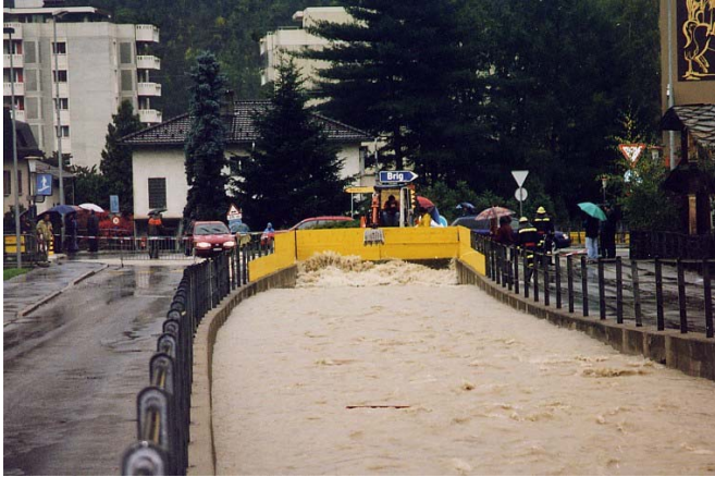
Figure 1: Pont de la route cantonale à Naters lors d'une crue de 40 \text{ m}^3/\text{s} en octobre 2000 / Bridge of cantonal road in Naters during a flood event of 40 \text{ m}^3/\text{s} in 2000
