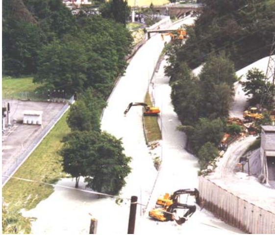
Figure 1: Purge de 1999, débordement dans le chenal de chasse de La Massa / Flushing of 1999, overflow in the Massa channel
