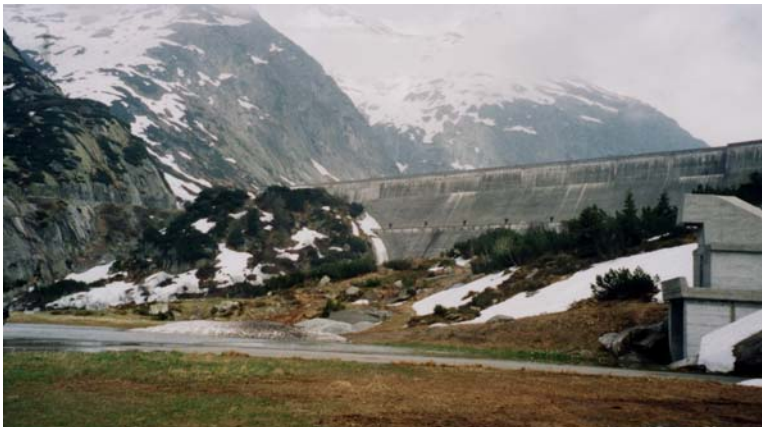
Figure 1: Barrage poids de Räterichsboden (97 m) / Gravity dam of Räterichsboden
