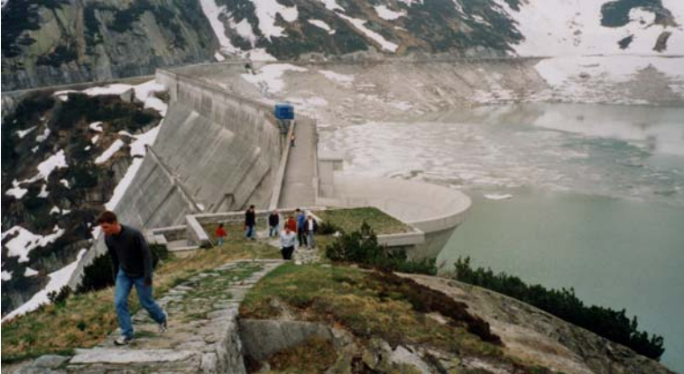
Figure 2: Barrage de Räterichsboden avec évacuateur de crues en demi-tulipe / Gravity dam of Räterichsboden with morning glory spillway
