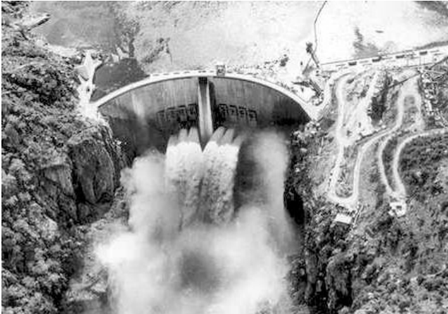
Figure 2: Ecoulement à travers 6 des 8 évacuateurs de crue munis de vannes du barrage de Cabora-Bassa / Discharge through 6 of the 8 orifice spillways at Cabora-Bassa dam, Mozambique
