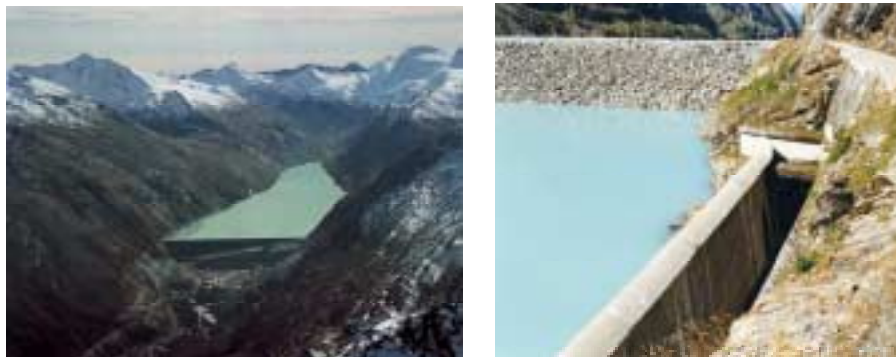
Fig.1: Barrage de Mattmark (à gauche) et évacuateur de crues à auge (à droite) Mattmark dam (on the left) and side weir spillway (on the right)
