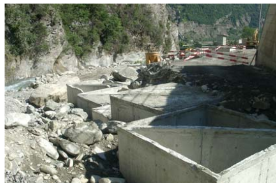
Fig. 4: Epi formés de demi-cubes de 27 t en construction
