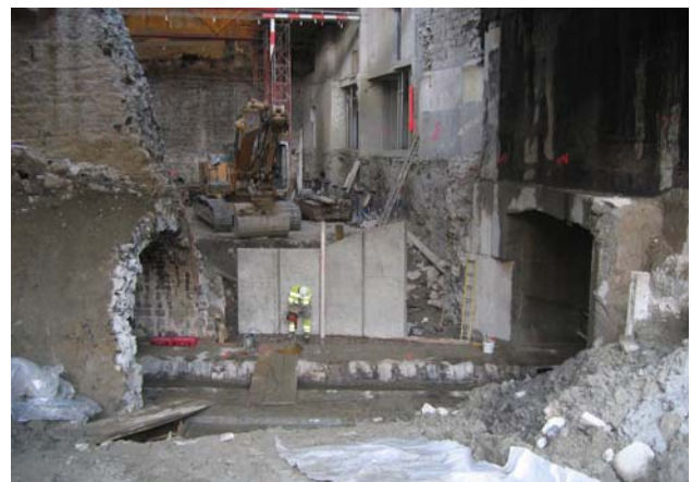
Fig. 3: Pose d'éléments préfabriqués pour le passage du Métro M2 sur le voûtage du Flon.
