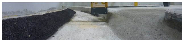
Figure 3 : Vue depuis l'amont de l'ouvrage de contrôle (G2)
