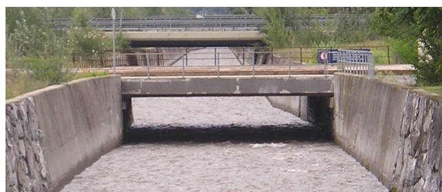
Figure 2 : Photo du pont CFF avant travaux, vu depuis l'amont
