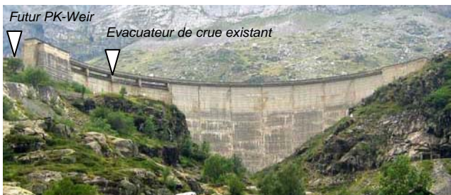
Figure 1: Vue d'aval de l'état actuel du barrage des Gloriettes
