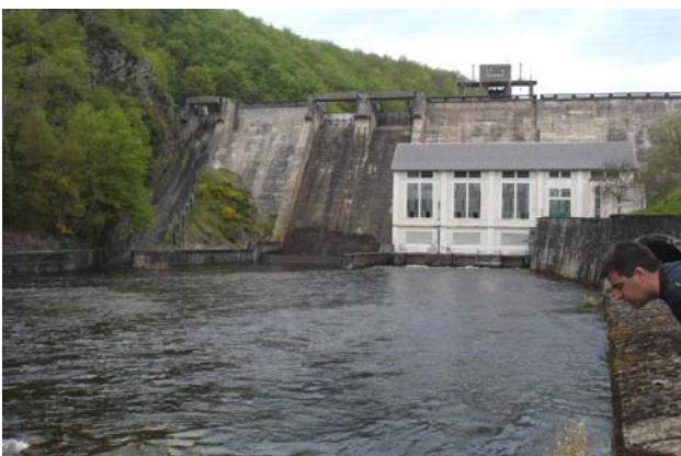
Figure 1: Vue d'aval de l'état actuel du barrage de St-Marc
