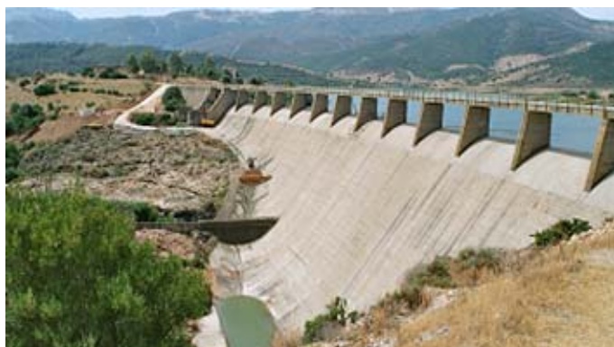
Figure 1: Vue du barrage de Maccheronis
