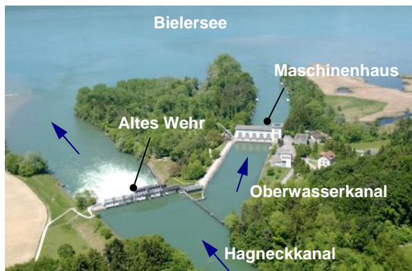
Abbildung 2: Luftbild der bestehenden Anlage (Quelle: www.bkw-fmb.ch, 13.01.2009)
