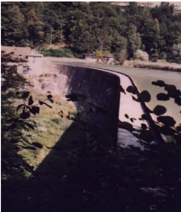
Fig. 1: Vue du barrage de la Maigrauge depuis la rive gauche.
