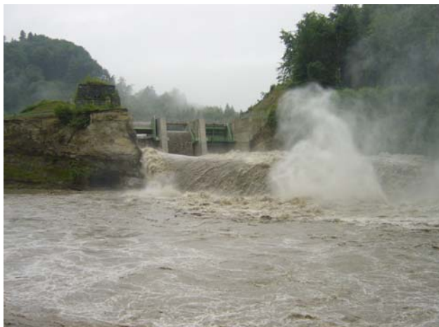
Figure 1 : Vue depuis l'aval de l'évacuateur de rive gauche. 22 août 2005 à 9h45
