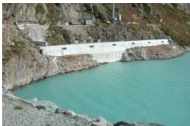
Fig. 1: Evacuateur de crue surélevé du barrage de Mattmark composé d'un déversoir à crête horizontale et de sept orifices.
