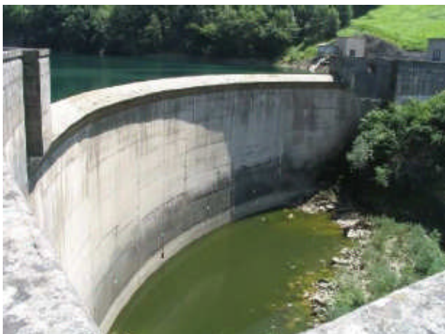
Figure 1: Vue d'aval de l'état actuel du barrage de Choranche
