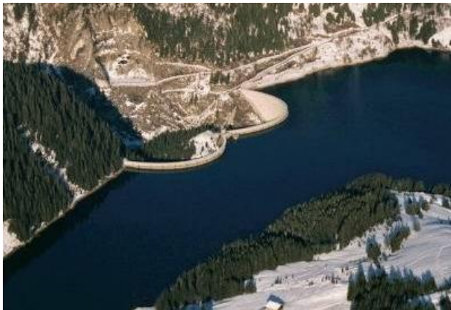
Figure 1: Vue du réservoir et des deux barrages-voûtes de Hongrin
