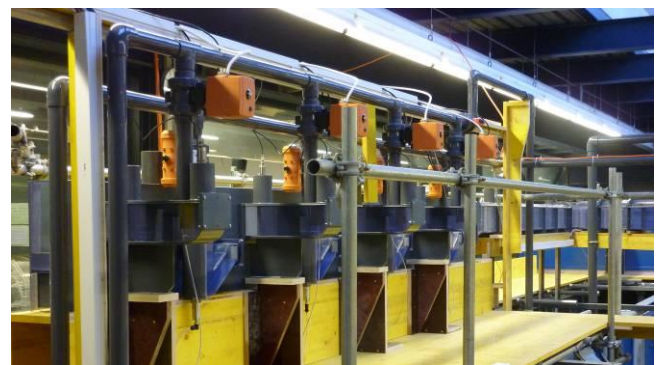
Figure 3: Modèle hydraulique du circuit hydraulique aval et de l'usine de pompage-turbinage Veytaux 1 avec ses quatre groupes
